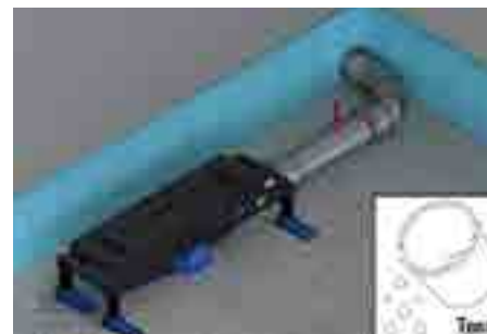
3. Отточната тръба се включва към една от трите възможни страни, свързва се с канализационната тръба и се проверява за водоплътност
