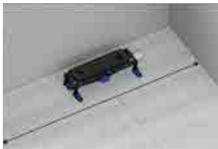
1. Тялото на сифона се позиционира и се закрепва към бетонната плоча
